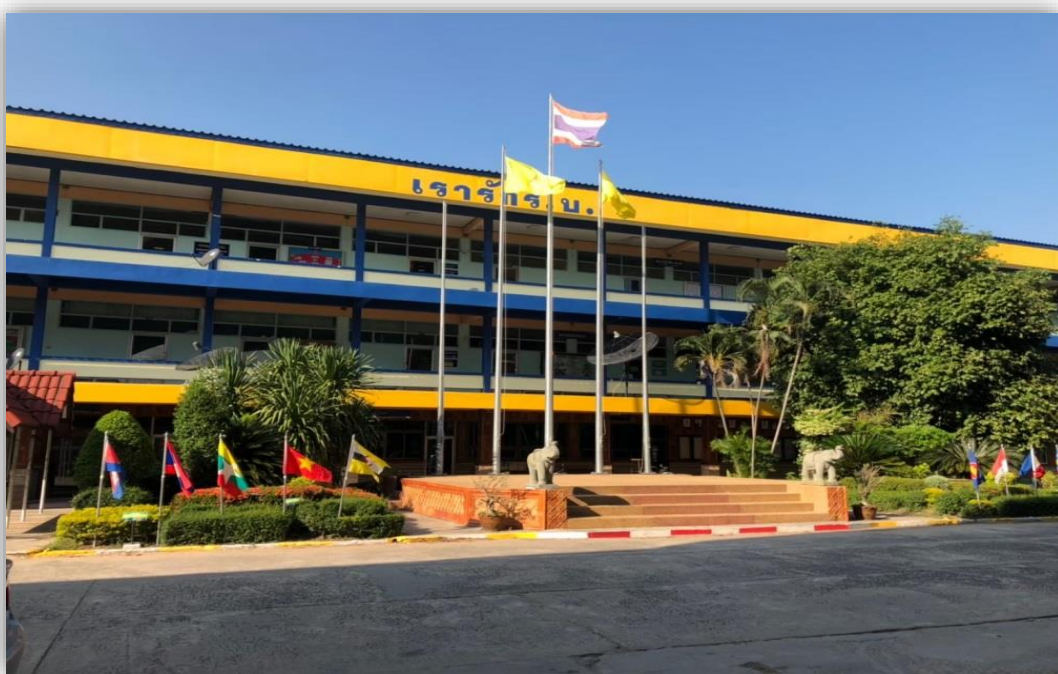
อาคาร ๑ ชั้นล่างเป็นห้องบริหารงานกลุ่มงานทั้ง ๔ ฝ่าย และห้องพักผู้อำนวยการ ชั้นบนเป็นห้องปฏิบัติการ เรียนการสอนกลุ่มสาระวิทยาศาสตร์ฯ
