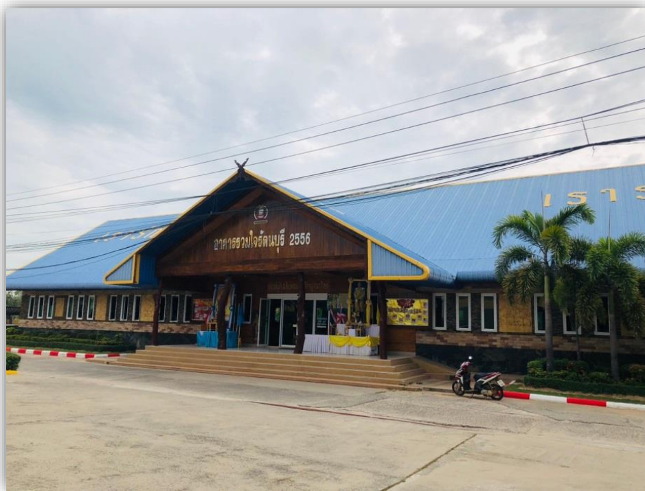
ห้องสมุดโรงเรียน อาคารรวมใจรัตนบุรี ๒๕๕๖ เป็นห้องอ่านหนังสือ และค้นคว้าความรู้ต่างๆของผู้เรียนและครู
